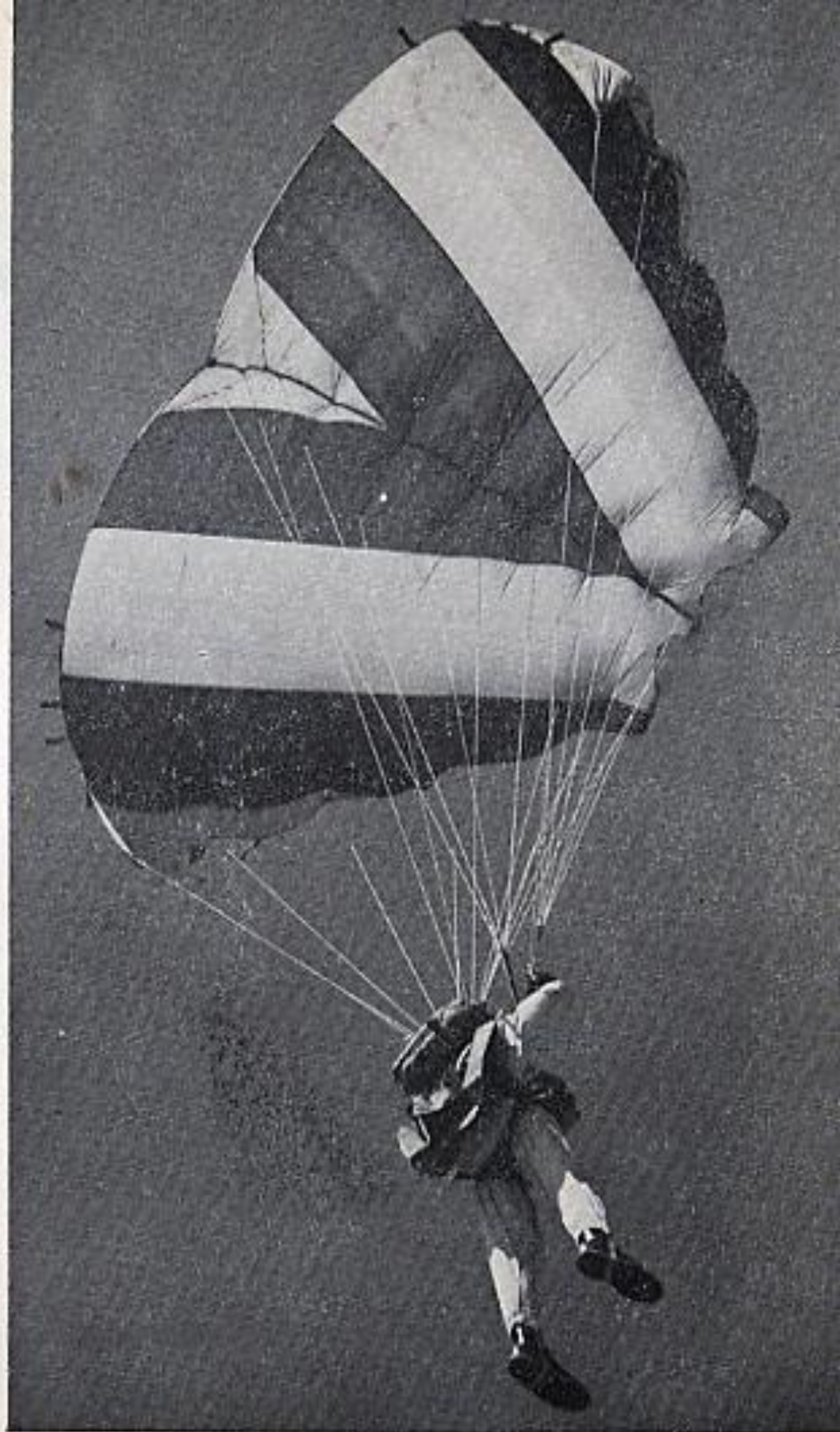
Novo modelo de pára-quedas — O Rogallo Flexwing
